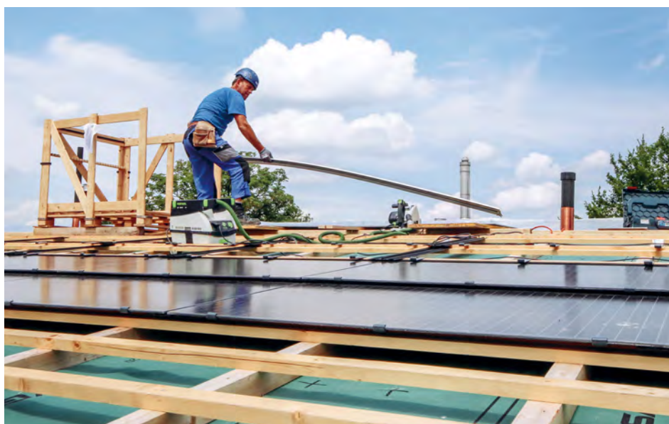
Eine Photovoltaikanlage wird auf dem Dach der Neubausiedlung Obsthalde fest installiert.
